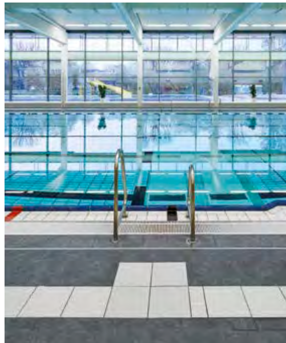
Kombibad Gropiusstadt · Gropiusstadt combination pool, Berlin, Deutschland · Germany / Architekt · Architect: Veauthier Meyer Architekten, Berlin, Deutschland · Germany Photo: Jochen Stüber
